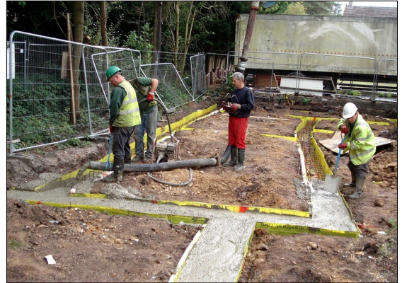
The first pour of concrete
